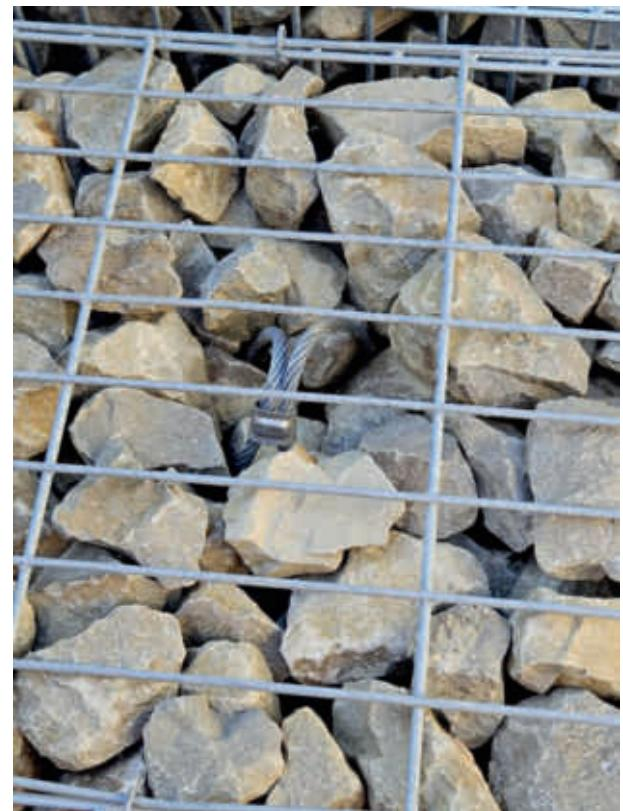
Mit Einführung der verzinkten Stahlseile werden die bisherigen Deckelgitter mit Öffnung nach und nach mit Deckelgitter ohne Öffnung ersetzt (Foto rechts).
